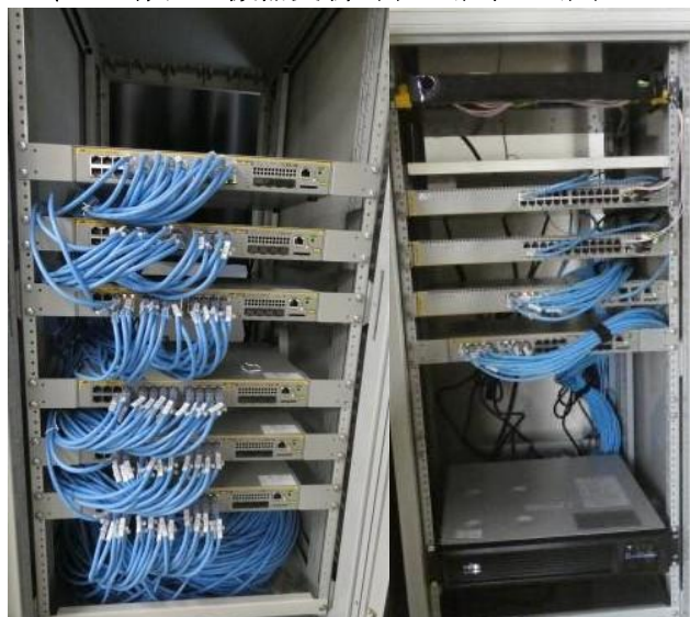
キャンパネットワーク機器更新 (エッジスイッチ、コアスイッチ)
